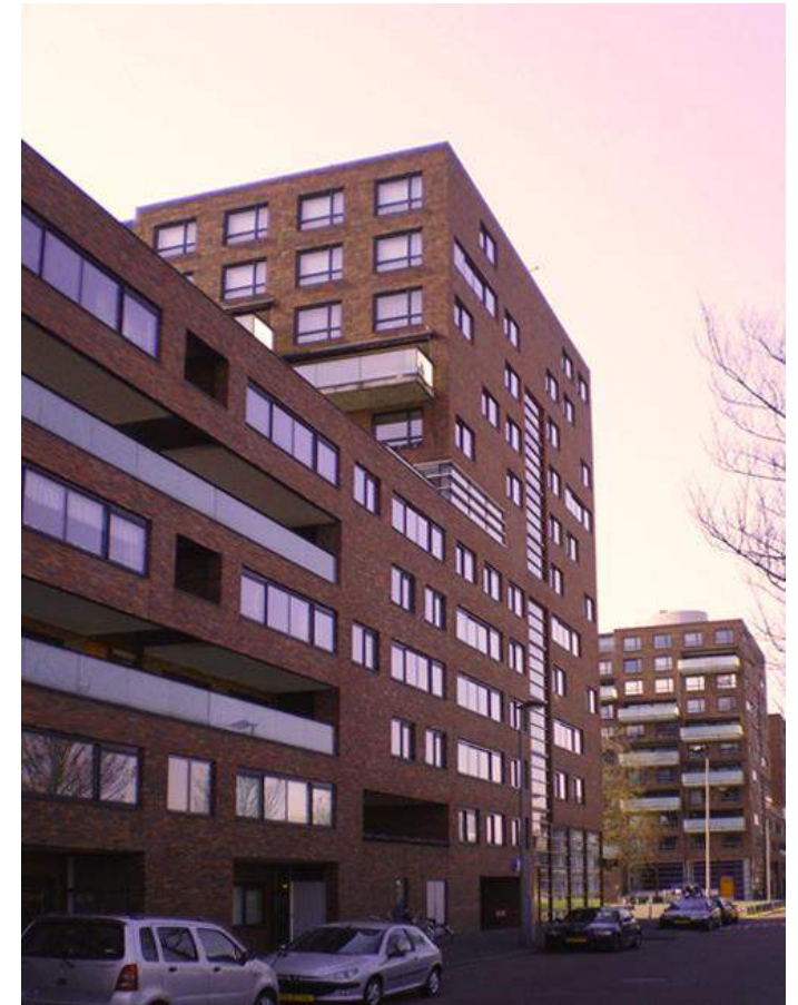
Lift en trappenhuis in het "lijf".
