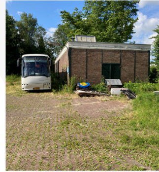
3. Noordervaartdijk 10, oude fietsenstalling
