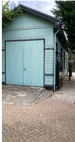
5. Achter Noorderhoofdstraat 22, voormalig spoorweg gebouw
