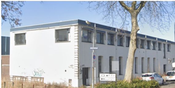
8. Noordervaartdijk 2, voormalig Spinnerij van de firma van Leyden. Het oorspronkelijke schuine dak is vervangen door een opgebouwde verdiepingen.
